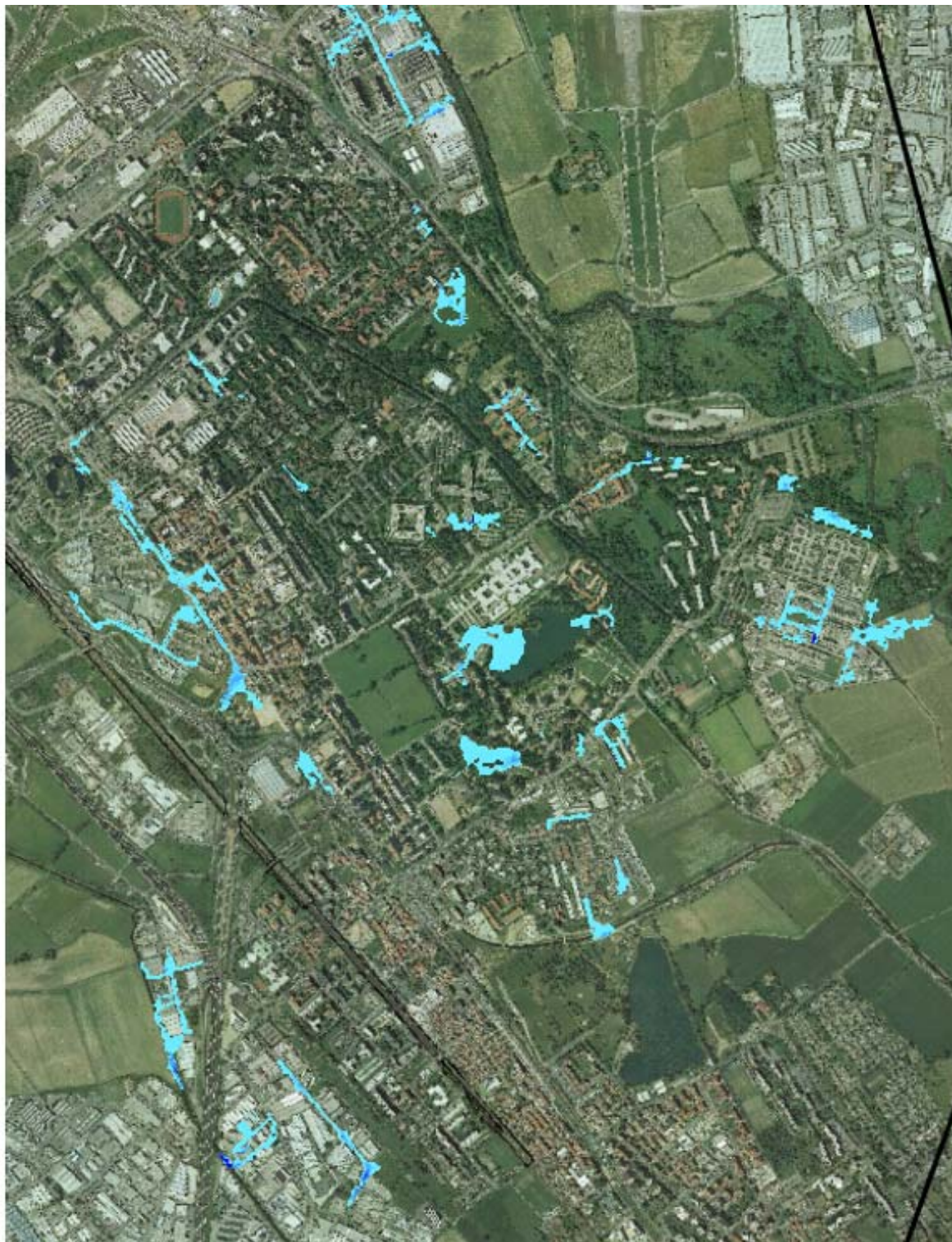
Figura 6.34 - Allagamenti stato di fatto T2 San Donato Est
