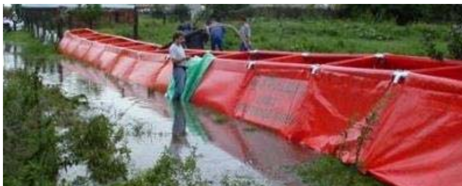
Figura 8.40 - Barriera temporanea antiesondazione riempita ad acqua
