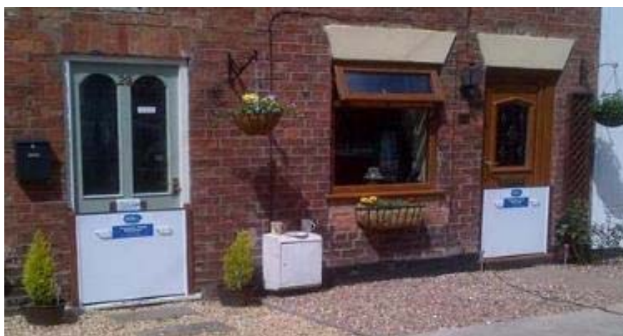
Figura 8.44 - Paratoie manuali a protezione di porte di ingresso
