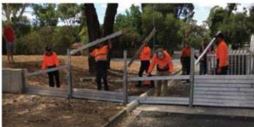
Figura 8.42 - Barriera temporanea modulare con pilastri e panconi manuali in alluminio
