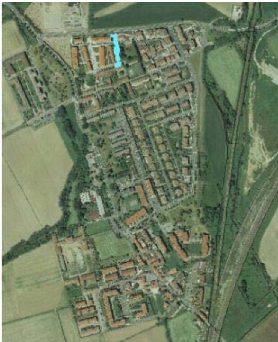
Figura 7.26 – Allagamenti stato di fatto T2 San Donato Ovest
