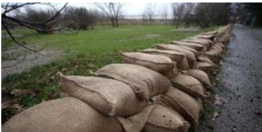
Figura 8.37 - Barriera temporanea antiesondazione in sacchi di sabbia
