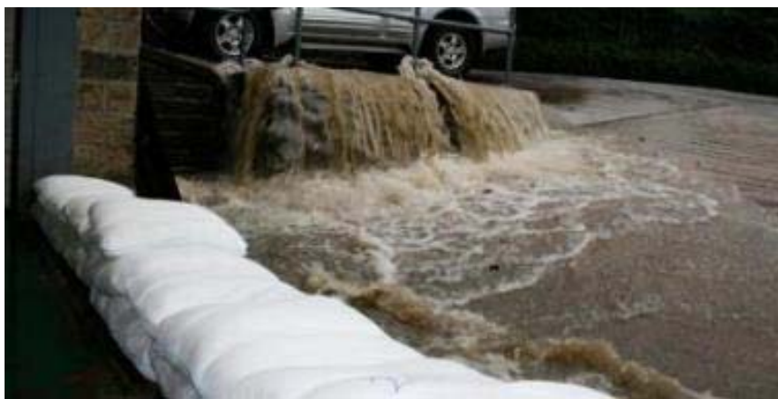
Figura 8.38 - Barriera temporanea in sacchi riempiti con materiale sintetico assorbente
