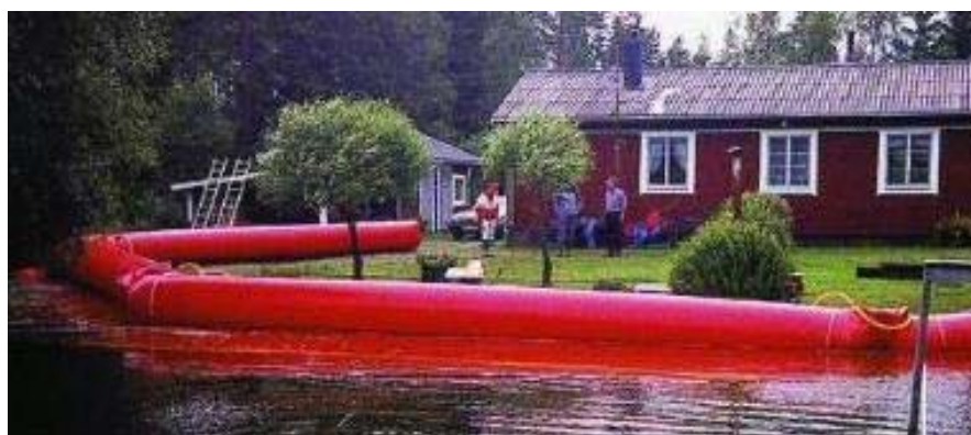
Figura 8.39 - Barriera temporanea antiesondazione riempita ad aria
