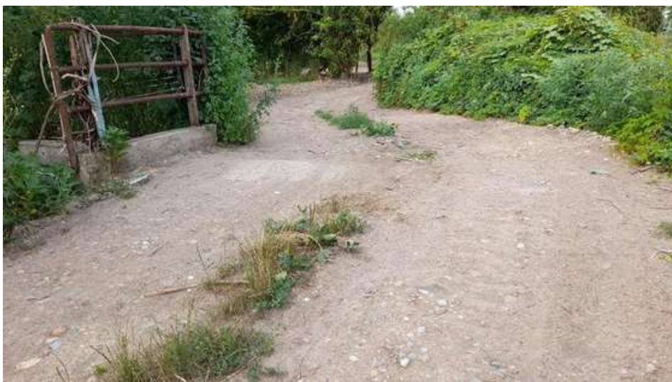
Figura 11 – Vista E post operam
