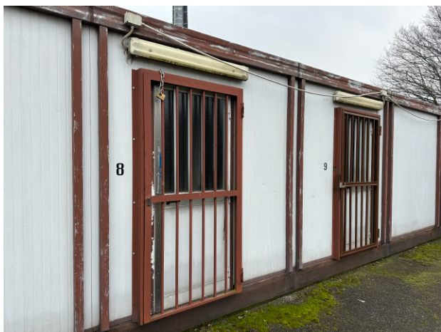
spogliatoi/servizi in prefabbricati
